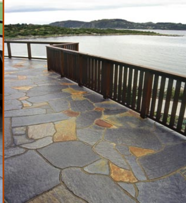
Terrasse i Ottaskifer - Pillarguri og rust.
